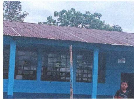
Foto 4: en este imagen se ve las laminas deterioradas que se nescita un buen matenimiento.
